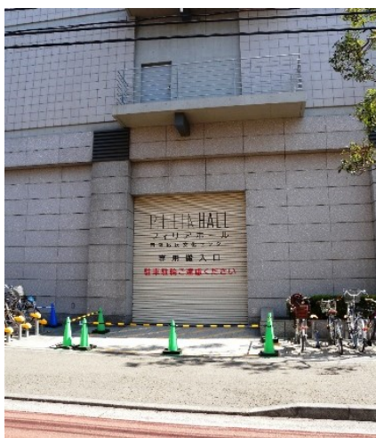
ホール搬入口
