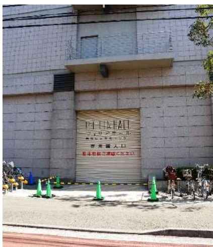
ホール搬入口
